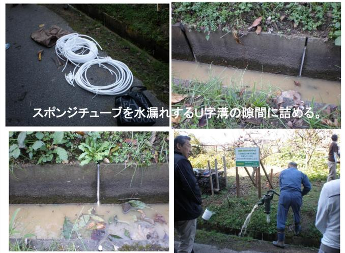
スポンジチューブを水漏れするU字溝の隙間に詰める。
