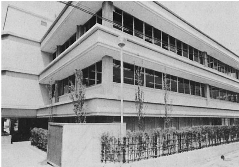
烏丸鞍馬口校舎の1号館の全景
