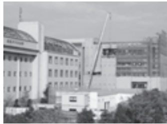
建設が進む新学科棟
